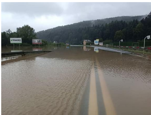
Fot. 2. – Witowice Dolne, droga krajowa 75 Nowy Sącz - Kraków (Fot. Marek Podmokły) (08.2021)
